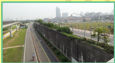
▲ กำแพงที่กั้นน้ำท่วมเข้าเมือง ชัยมือคือพื้นที่สาธารณะและทางจักรยานริมน้ำที่อาจปล่อยให้ท่วมได้ในหน้าน้ำ ส่วนขวามือคือเขตป้องกันน้ำท่วมซึ่งเป็นบริเวณที่ตั้งของเมืองและไม่ยอมให้น้ำเข้ามาท่วม, ไทยปี 2015
